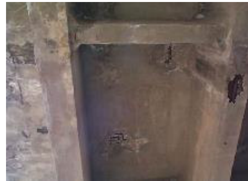
Spalling
