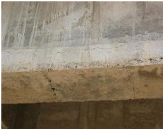
Longitudinal Crack in Gir. Bottom
